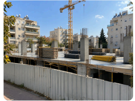
מבט כללי על האתר - רצפת קומת הקרקע יצוקה
