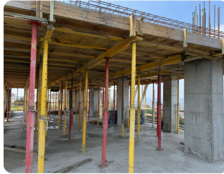
הכנות ליציקה רצפה קומה 1 - טפסנות וברזל
