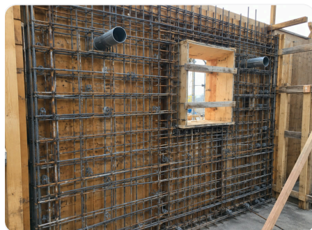
ברזל קיר ממ"ד בקומה 4 לפני סגירת התבנית
